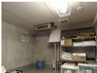
給気口近傍の天井面に機器を取付けてください。
